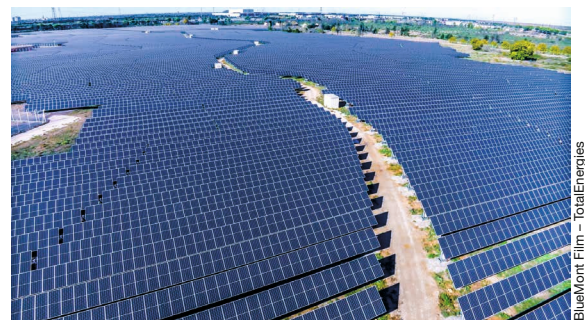
Centrale solaire de La Feuillane (Bouches-du-Rhône).
